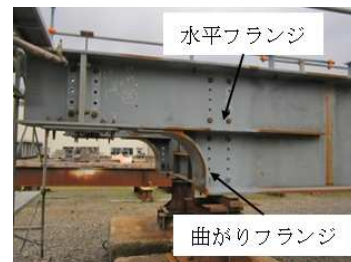
写真-3 差し込みフランジ構造
