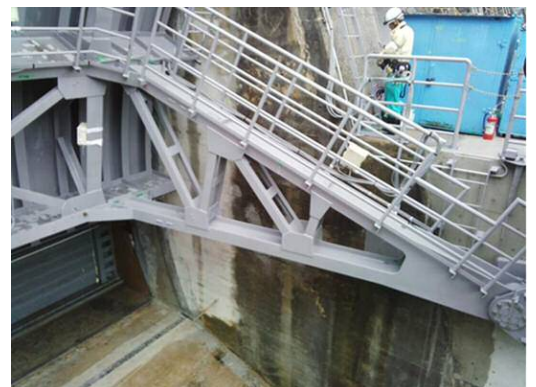
(a) 新設ゲートの脚柱構造
