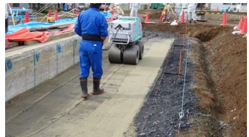
図-2 小型振動ローラによる転圧
