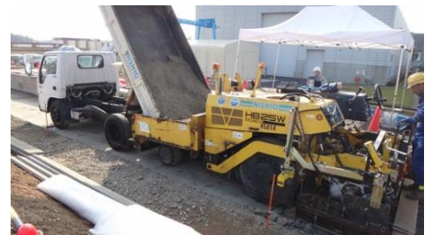
図-1 小型フィニッシャによる敷均し
