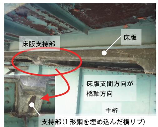
図-2 4 主鉄桁の RC 床版
