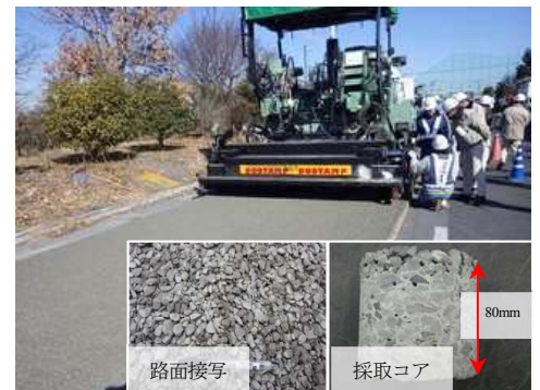
写真-2 ハイブリッド Con 施工状況
