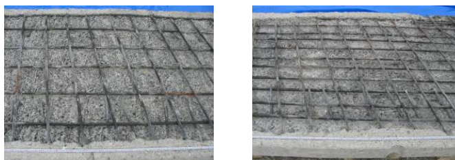
図-2 既設床版上面はつり後の鉄筋状況
