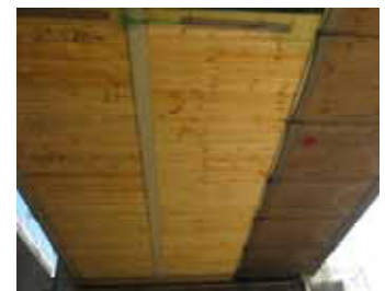
写真－4 板張り防護の設置
