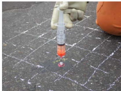
写真 3 特殊樹脂注入状況
