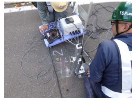
写真 4 i-scope 作業状況
