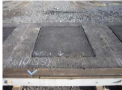
写真 7 アスファルト版 設置状況
