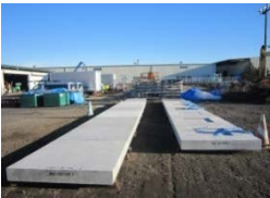
写真 2 RC 版群 アスファルト版設置前
