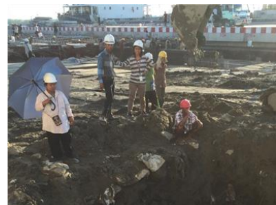
写真2 土工事の指示をする副所長(中央)
