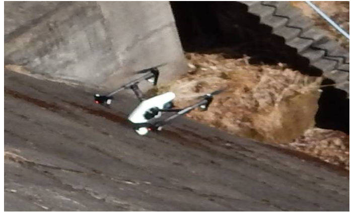
写真3 近接で花貫ダムの調査撮影を行う UAV
