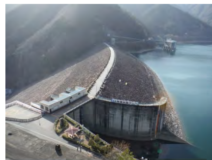
図1 対象ダム堤体(左岸側)
