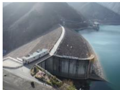
図 1 対象ダム堤体(左岸側)
