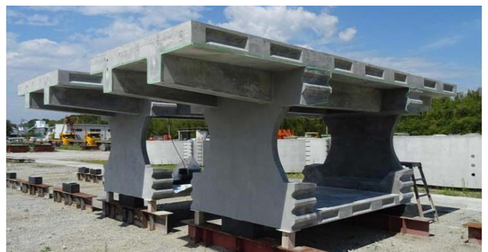
写真-1 セグメント製作状況
