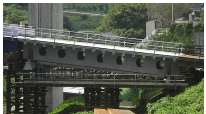
写真-2 実証橋完成状況
