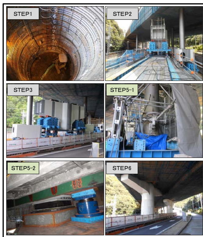
写真-2 中間橋脚の構造変更ステップ状況
