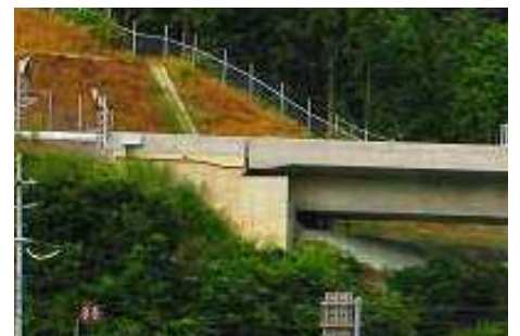
写真-2 沓隠し壁とフェイスライン
