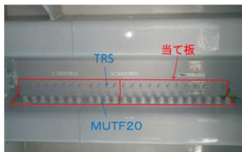
写真 - 5 当て板設置完了状況
