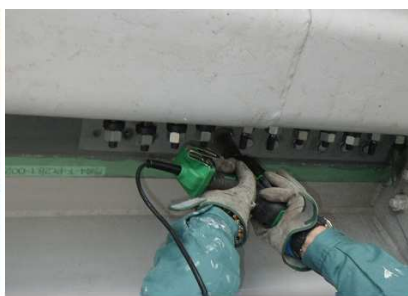
写真 - 4 TRS φ16 締め込み状況
