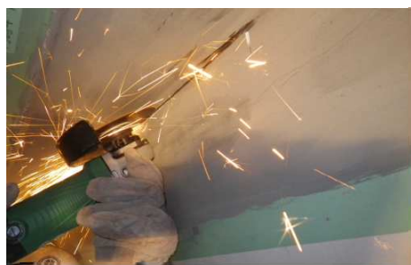
写真 - 2 溶接部切削状況
