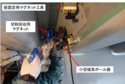
写真 - 3 TRS 用ボルト孔削孔状況
