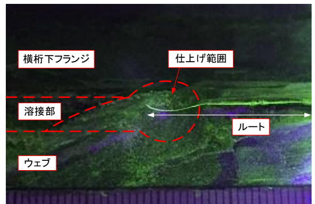
写真-3 試験部 B' のビード先端の仕上げ状況
