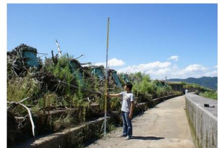
写真-1 熊本県一の宮多目的貯木池における流木捕捉状況 [2013年7月撮影]
