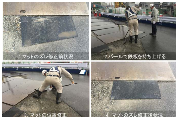
図-7 スロープマットのズレ修正状況
