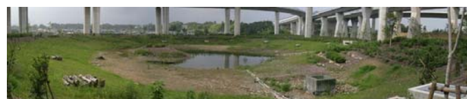
写真-1 整備直後の状況 2005. 7
