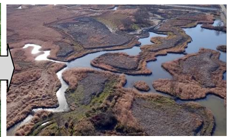
図-12 施工後のハビタットエリア
