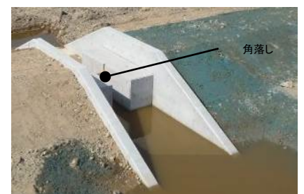
図-6 角落しのある越流堰
