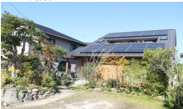
写真-1 雨水利用実験住宅外観
