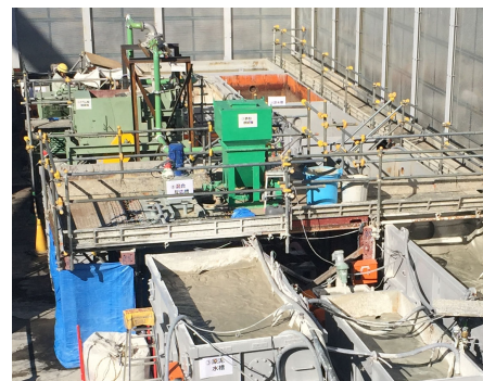
写真-1 浄化プラント設置状況
