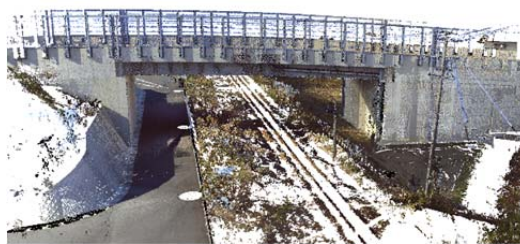
図2 対象橋梁の点群可視化
