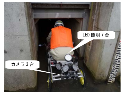
図-1 樋門点検機械 (走行式、2014 年開発)
