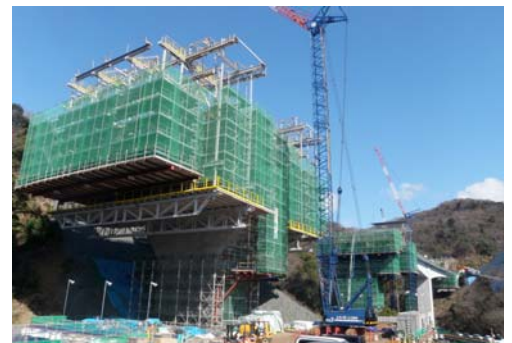
写真-1 工事状況
