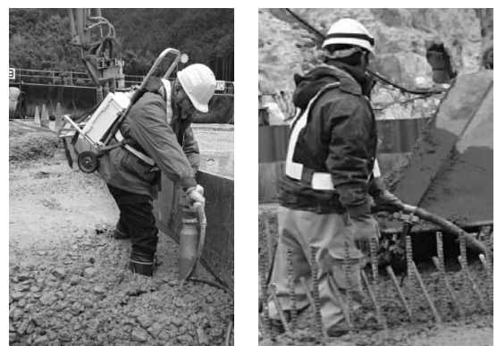
写真-3 現場での実験状況（2タイプ）
