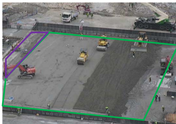
図-5 作業状況(同機表示)
