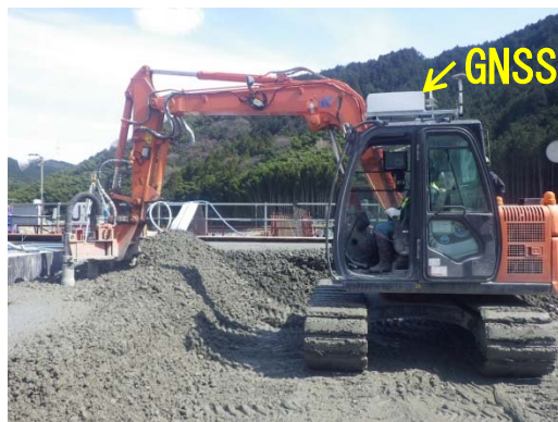
図-2 バイブレータ締固め状況
