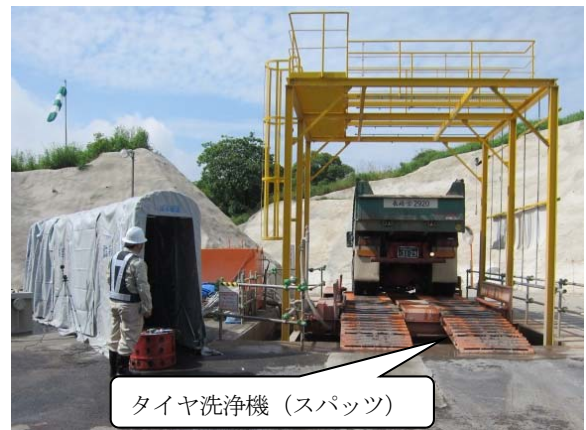
写真-2 実証試験の状況
