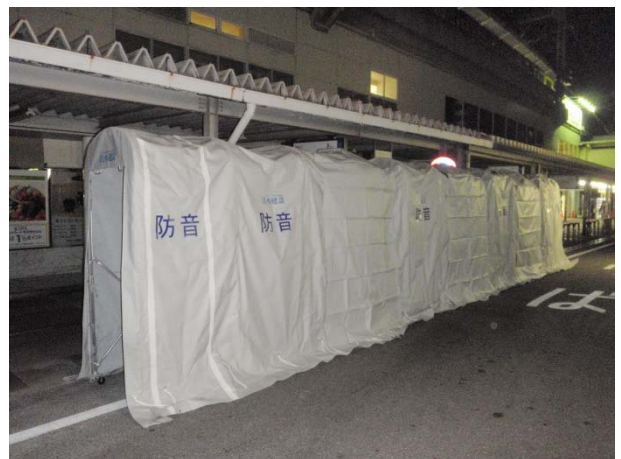
写真-1 夜間工事の利用状況
