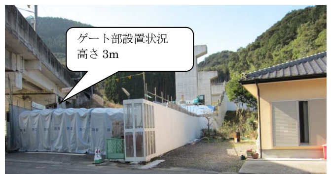
写真-4 ゲート部に配置したアコーデオン防音壁
