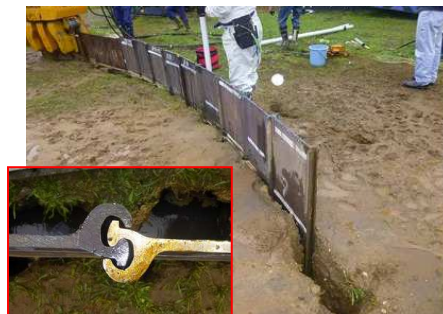
写真4 油圧圧入の施工出来形
