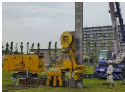
写真3 油圧圧入施工状況
