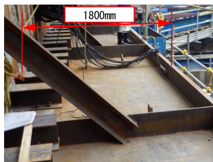
写真-2 BH 腹起し
