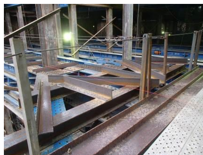
写真-1 集中切梁南側補強状況
