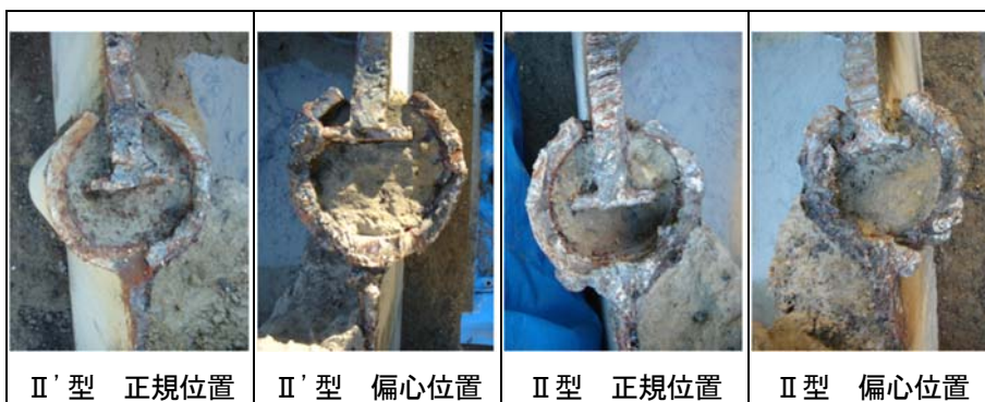
写真-3 継手内の充填状況
