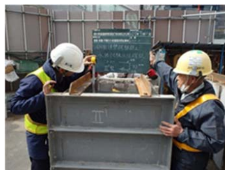
写真-2 水張り試験状況(水位測定)
