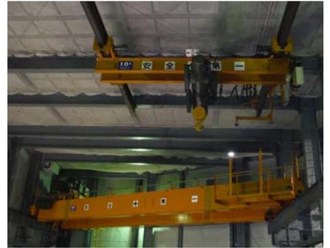
写真-4 ハウス内天井クレーン
