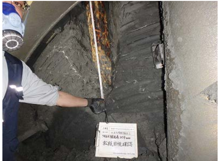
写真 1 切羽部松杭出現状況
