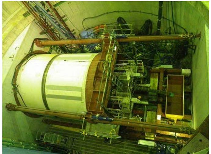
写真 1 センターホールジャッキ方式による仮発進
