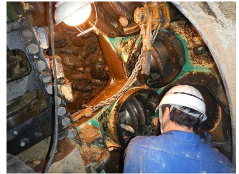
写真-1 ビットの交換状況
