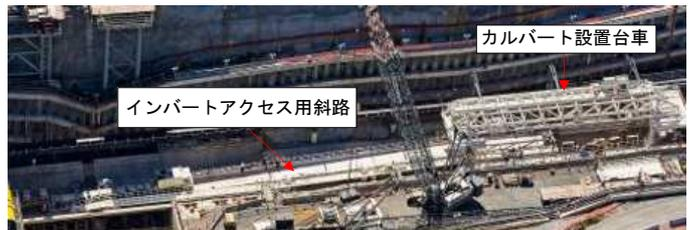
図7 カルバート設置台車(組立状況)
