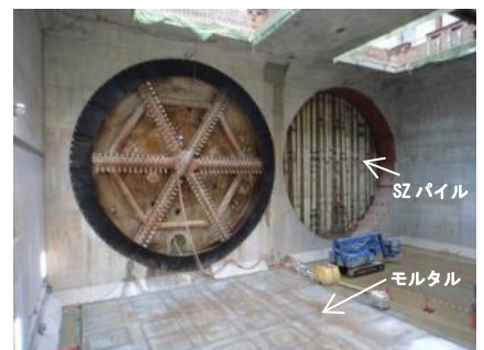
写真-1 (左)シールド到達(右)SZパイル(下)モルタル打設
