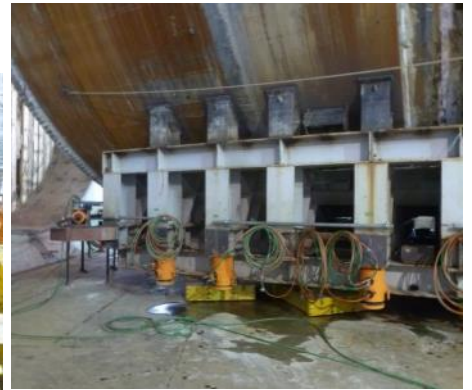
写真-3 ボールスライダー(右:設置状況)
