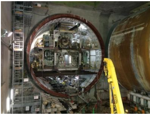
写真-2 マシン一部切離し
