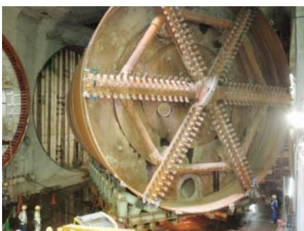
写真-4 センターホールジャッキ牽引状況
