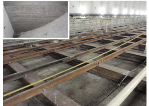
写真-1 流動化処理土の打設完了状況
