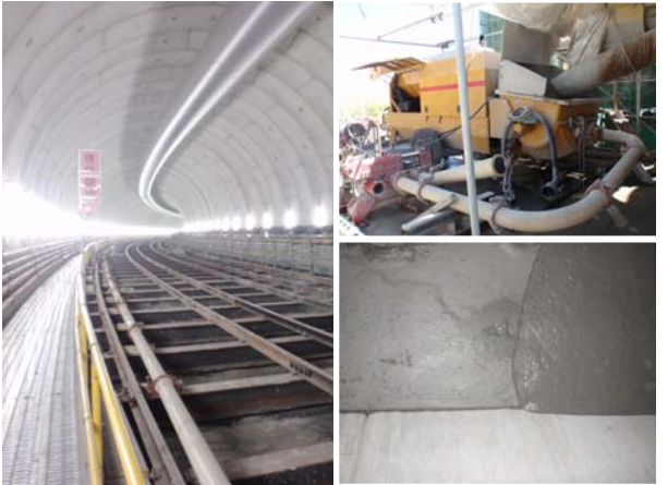
写真－3 流動化処理土の打設状況
