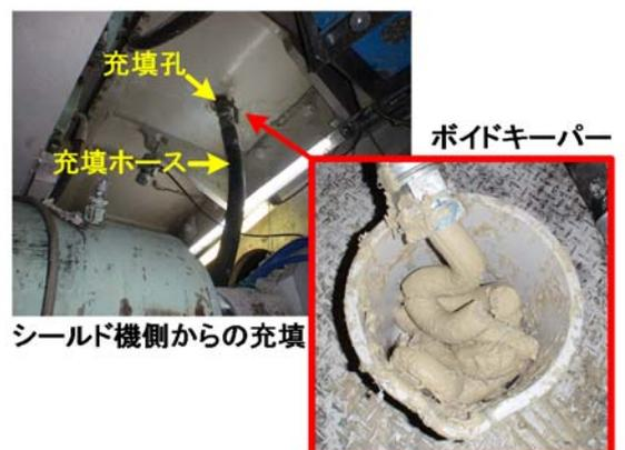
写真-1 現場でのボイドキーパー充填状況
