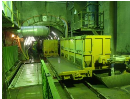
写真-1 スライド鋼車施工状況
