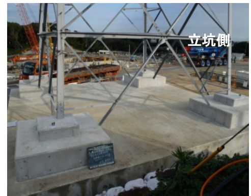
写真-1 送電鉄塔基礎の補強状況
