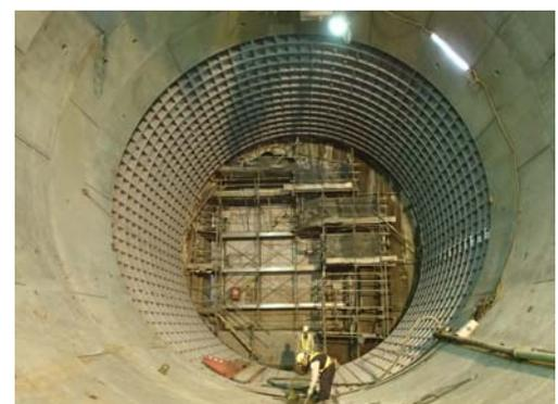
写真-4 機内覆工セグメント施工完了
