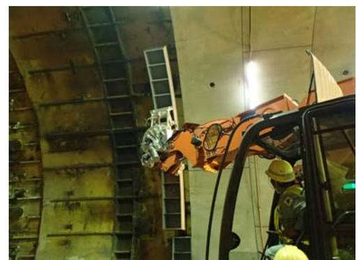
写真-3 機内覆工セグメント施工状況
