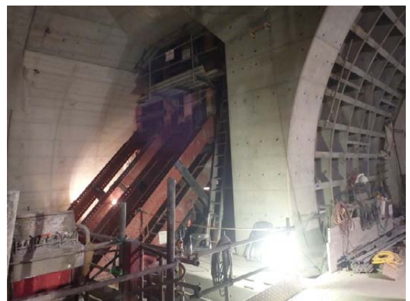
写真-1 仮壁および反力支保工設置状況
