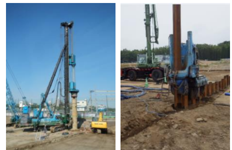
写真-1 ロックオーガー+サイレントパイラー
