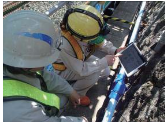
写真-1 現場での導入の様子
