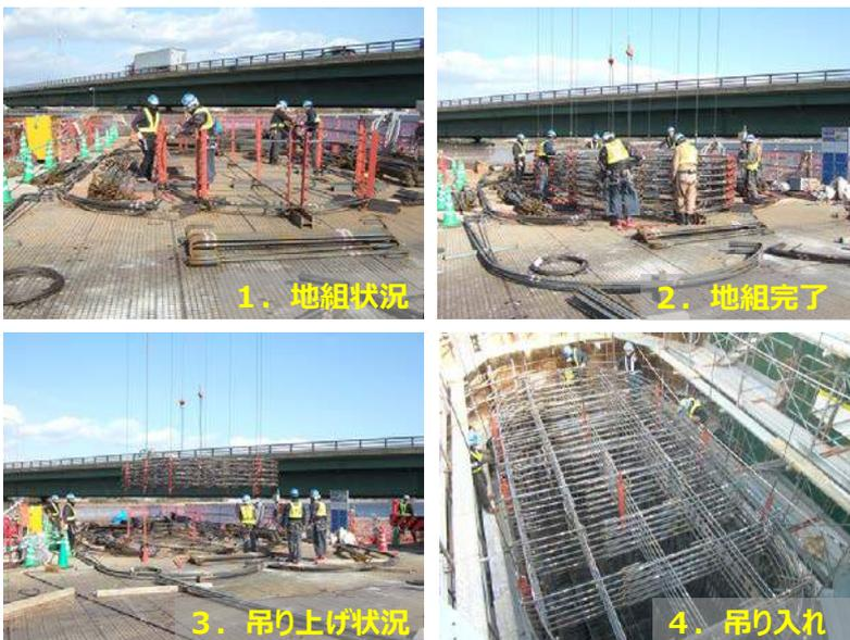
写真-2 地組装置による鉄筋組立
