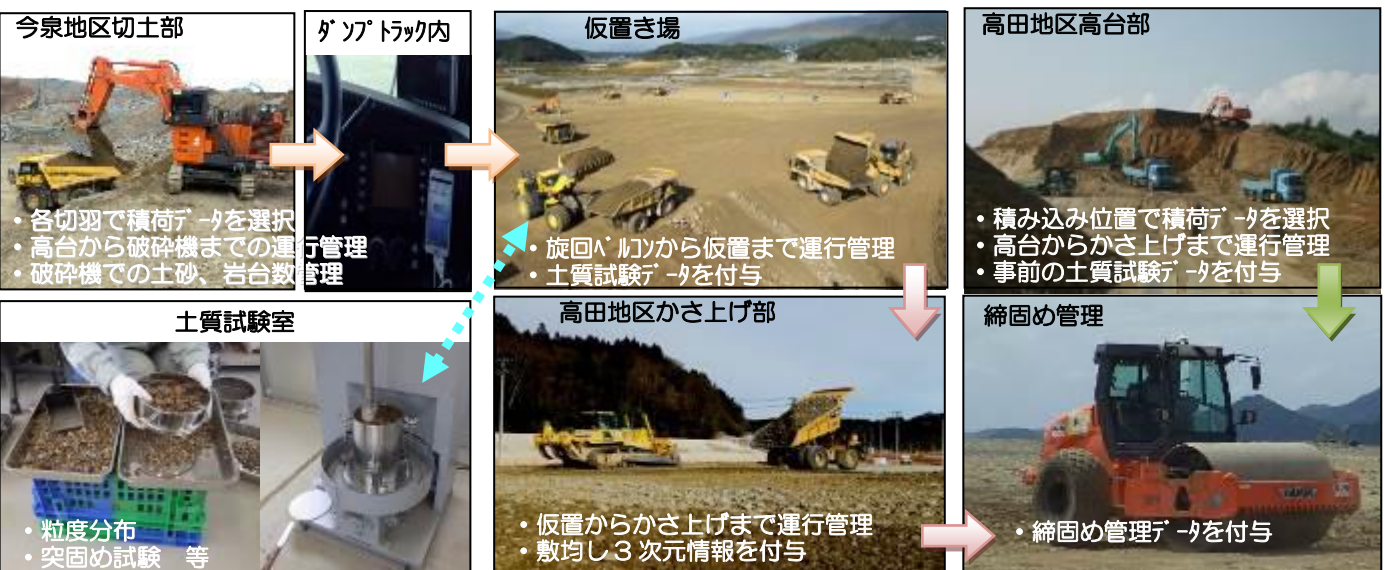
図-2 盛土材料のトレーサビリティ管理
