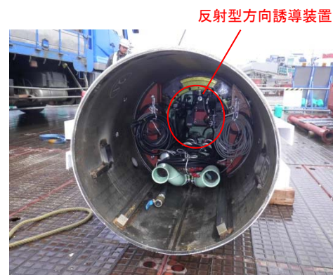
写真-1 パイプルーフ鋼管内
